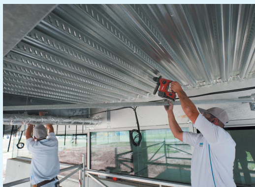
Mise en place des suspentes
