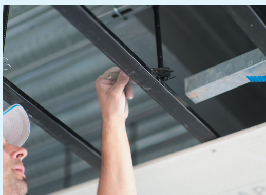
Traitement des goupilles avec peinture anti-corrosion
