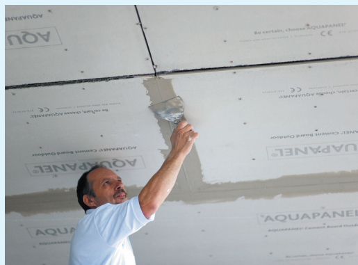
Traitement des joints
