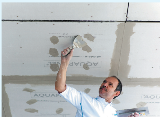
Traitement des têtes de vis
