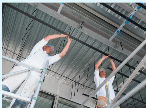
Fixation des fourrures F47H
