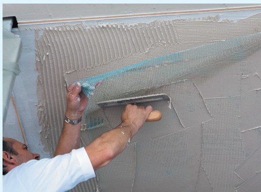
Pose du treillis de renfort
