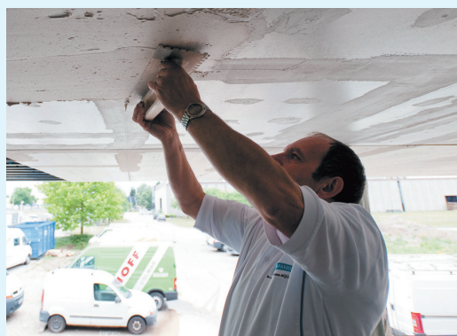
Application de l'enduit d'armature plafond
