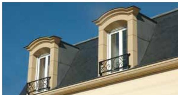
Les lucarnes Weser sont composées de 4 ou 5 éléments qui s'assemblent par emboîtement, collage et clavetage.
