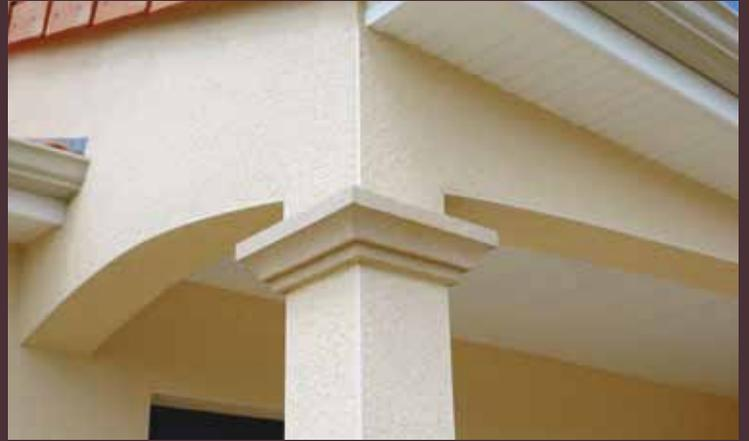
Les chapiteaux moulurés de section carrée sont couramment utilisés pour enjoliver les poteaux support de terrasses et d'auvents. Une bande résiliante (film compressible) est à prévoir pour la mise en œuvre afin d'éviter les risques de fissuration par dilatation.
