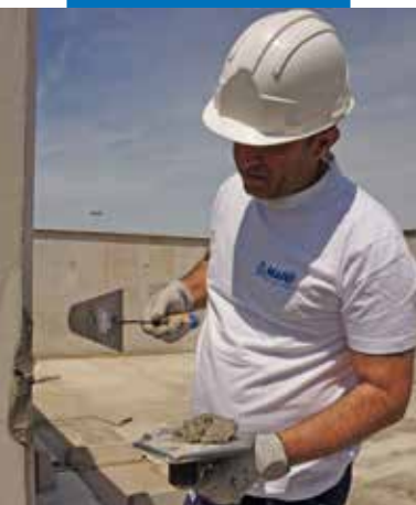
Application du mortier par couches successives selon l'épaisseur à réparer
