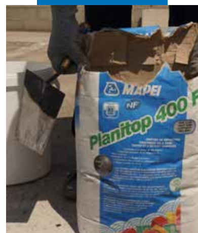
Préparation de la gâchée
