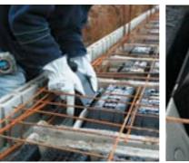
3 - Mise en place de l'Aéro VS : clipser les AéroVS sur les Tympans concernés, grâce à la zone d'accostage prévue à cet effet.
