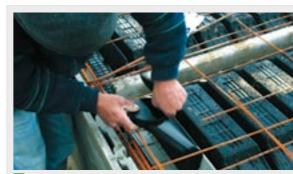
Cas N°2: retirer les protections du conduit de ventilation et emboîter fermement une sortie de diamètre 100 mm - non fournie - (côté femelle vers l'AéroVS). Obligatoire pour des épaisseurs de plancher supérieures à 17 cm
