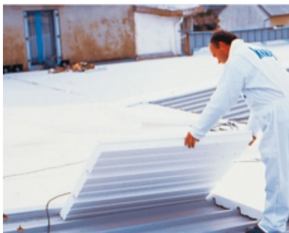
Pose des panneaux
