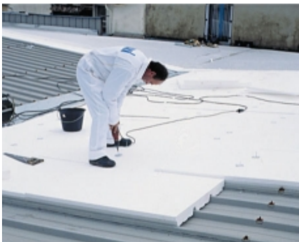
Fixation des panneaux
