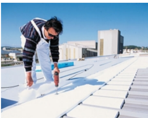
Fixation des panneaux
