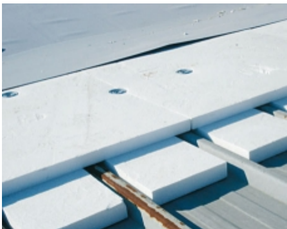
Pose des languettes et des panneaux
