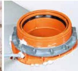
Avec la cartouche et l'embout plastique, la résine est injectée par le point d'injection situé dans la bague de compensation orange.
