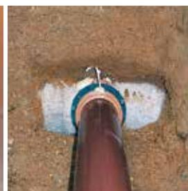
Pièce de piquage montée avec une sortie en tuyau HSK.
